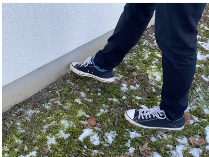
Næstformanden viser hvor strømledningen kommer ud af bygningen
