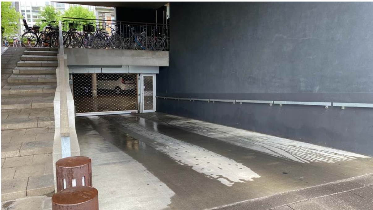
Nedkørsel til parkeringskælderen.
